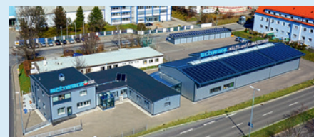
2010 | Erweiterung des Betriebs mit PV-Anlage
